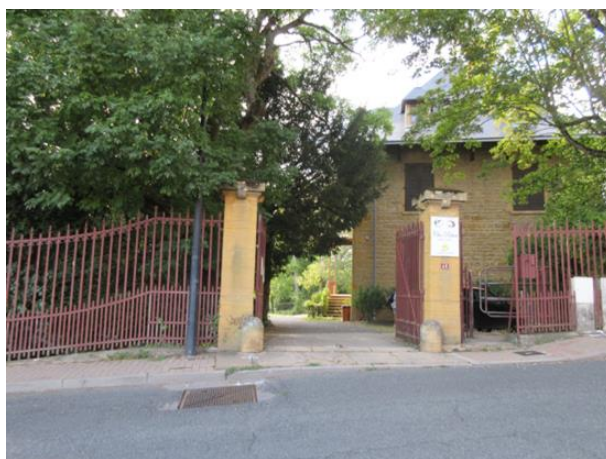
Le petit trottoir actuel et le portail trop étroit
