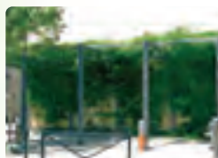
Arrêt de bus végétalisé Le lierre apporte ombre et fraîcheur
