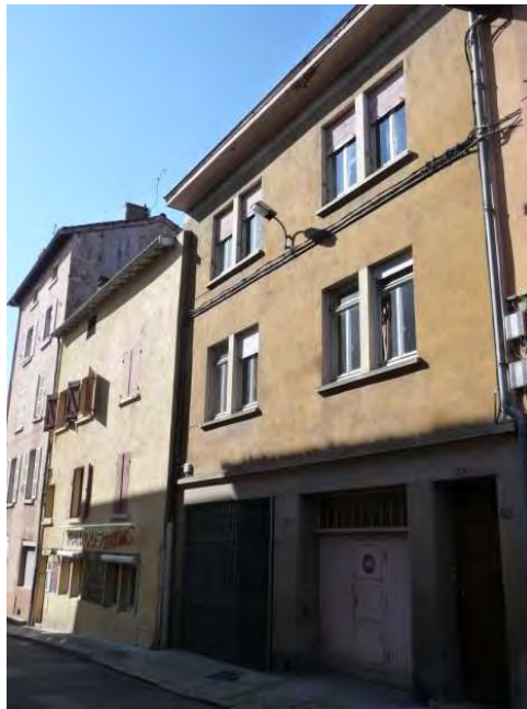
Exemple d'un édifice caladois (à gauche) supportant parfaitement une isolation par l'extérieur : pas de modénature et un recul suffisant par rapport aux façades de part et d'autre, et autre exemple (à droite) d'un immeuble où l'isolation par l'extérieur n'est pas envisageable
