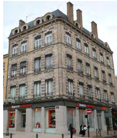
Immeuble intégralement en pierre de taille
