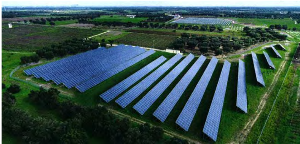
Impact d'un champ de panneau photovoltaïque dans le paysage à Puglia en Italie Brochure S.A.G. Solaire-France
