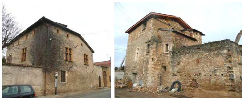
Maison en du XVI e siècle en maçonnerie de pierres à bâtir devant être enduite... Maison en maçonnerie de pierres à bâtir devant être enduite...
