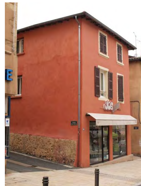
Exemple d'un enduit traditionnel à base de chaux aérienne naturelle
