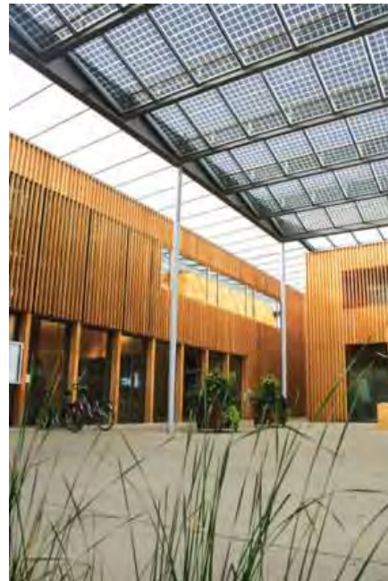
Hall de bureaux couvert par des panneaux photovoltaïques Source internet www.consoneo
