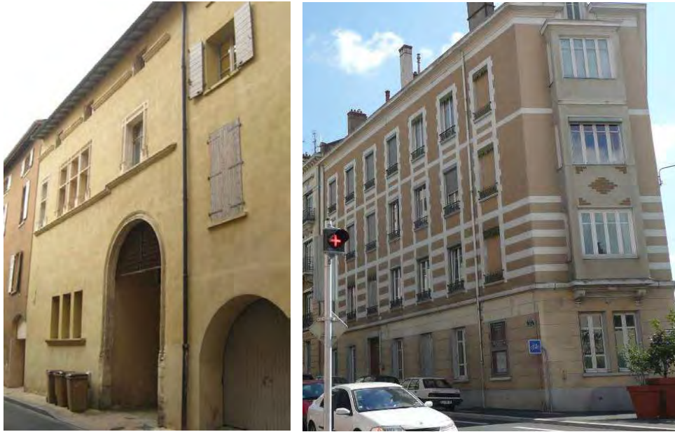
Exemple de construction anciennes, antérieures aux années 1950, réalisées avec des matériaux de provenance local et qui ont une très bonne inertie thermique
