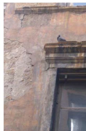
Etat de l'enduit
