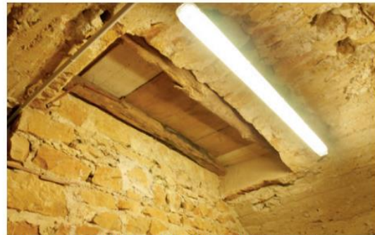
Cave 2, ancienne trémie permettant l'accès à l'étage supérieur
