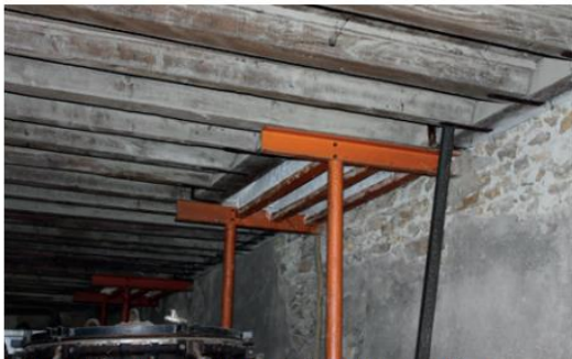
Bâtiment B, renforts sous les cheminées de l'étage supérieur
