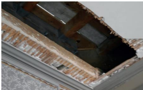
Bâtiment A, intervention sur la ferme nord
