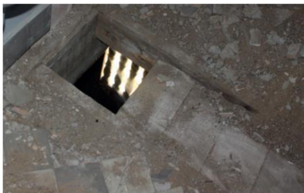
Bâtiment C, sondage du plancher dans les sanitaires
