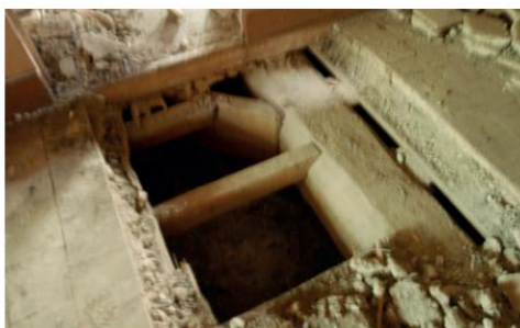
Bâtiment A, sondage sud du plancher des combles situé au sud. Ici la poutre est en bon état
