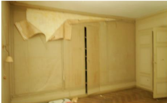
Bâtiment A, salon 1
