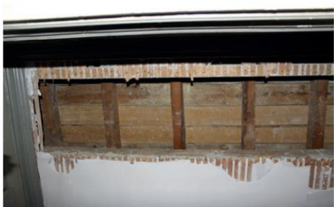
Bâtiment A, sondage nord vu depuis le plafond de la chambre 1: entrain, lambourdes et voliges supportant le sol en tomettes
