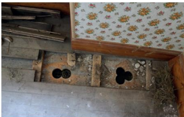
Bâtiment C, sondage du plancher dans la chambre
