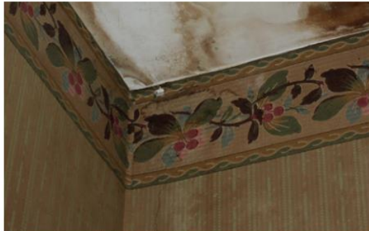
Bâtiment C, couloir du premier étage
