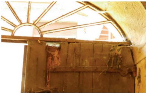
Bâtiment A, portail d'accès aux caves
