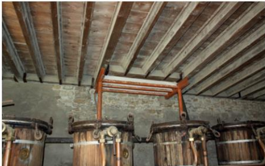
Bâtiment B, solivage du hangar
