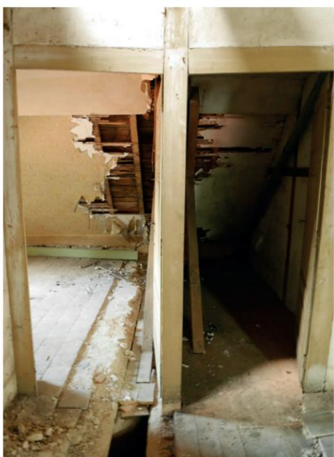
Bâtiment A, sondage «nord» du plancher des combles
