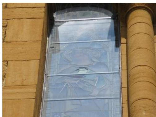
Protections grillage des vitraux déchirées    Réparation vitrée réalisée en 2024 sans restauration
