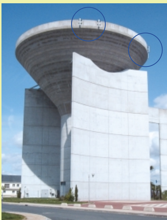
A. Antennes posées en applique sur la paroi du château d'eau
