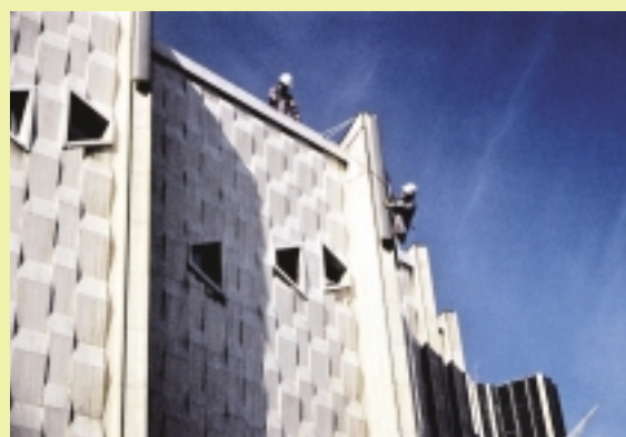
Antennes installées dans la ligne verticale du bâtiment
