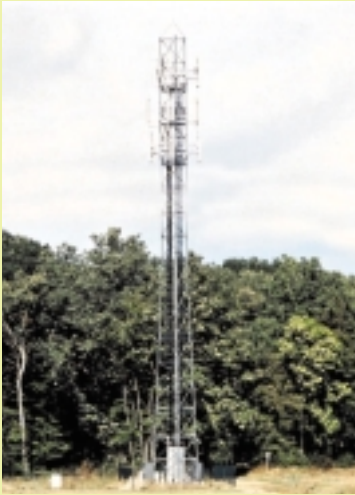
Cohabitation : antennes des trois opérateurs de téléphonie mobile installées sur un même pylône
