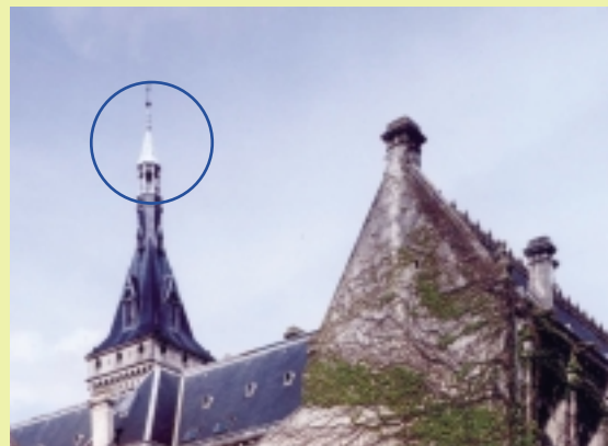
B-C. Antennes installées dans le respect du style architectural des bâtiments
