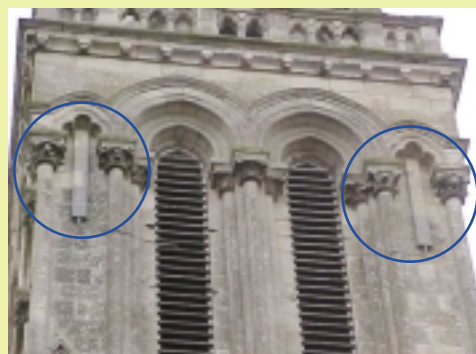
Antennes peintes en trompe-l'œil, posées sur une paroi d'église
