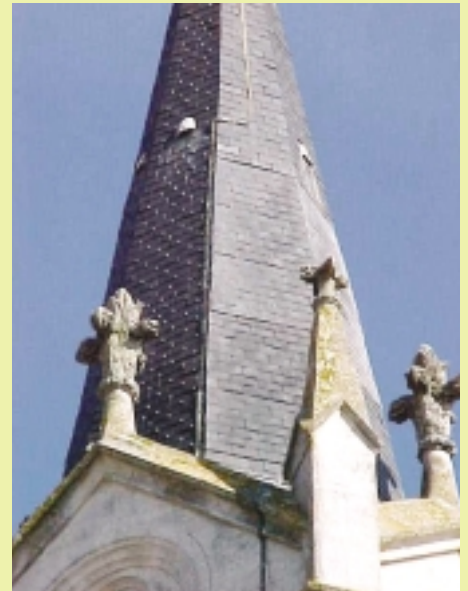
Antenne installée dans un clocher derrière un écran d'ardoises synthétiques
