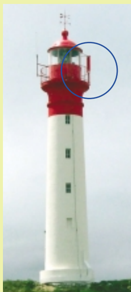
Antennes peintes en rouge posées sur le garde corps du phare
