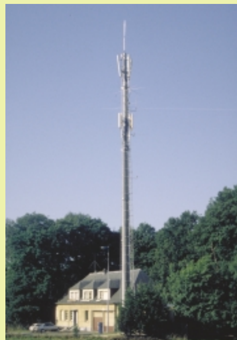
Colocalisation : antennes de téléphonie mobile sur le pylône d'une Direction Départementale de l'Équipement
