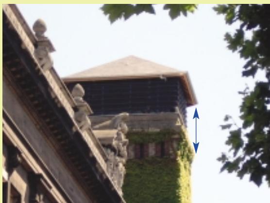
Tour rehaussée pour héberger l'antenne-relais
