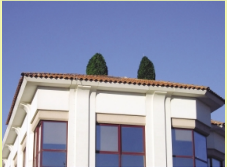
A. Antennes en bordure de toit, dans un habillage de végétation synthétique
