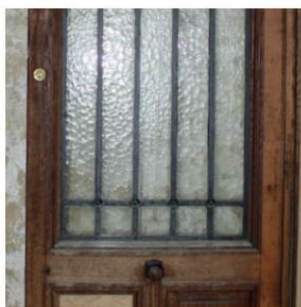
Cage d'escalier, porte d'entrée
