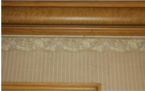
Salle de billard, corniche de couronnement en plâtre imitation bois
