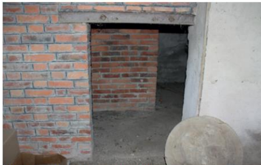
Atelier, percement menant sous l'escalier
