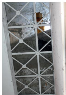
Ouverture zénithale de la salle de bains. Une trappe à côté permet d'accéder aux combles du bâtiment C.
