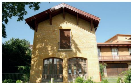
Bâtiment C, façade ouest donnant sur le parc
