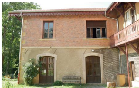
Bâtiment C, façade sud
