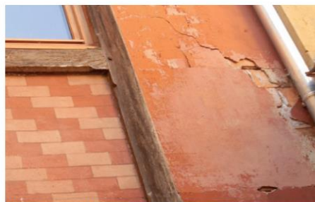
Bâtiment B, détail de composition et finition de la façade sud
