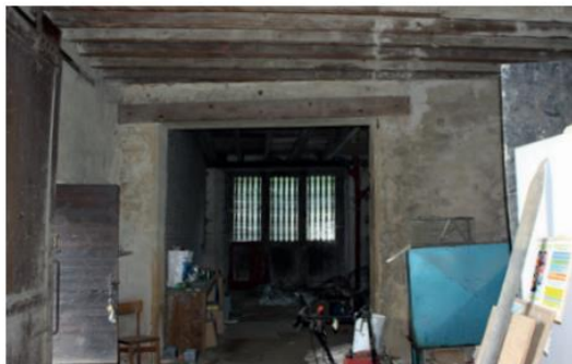
Vue de l'atelier depuis le hangar
