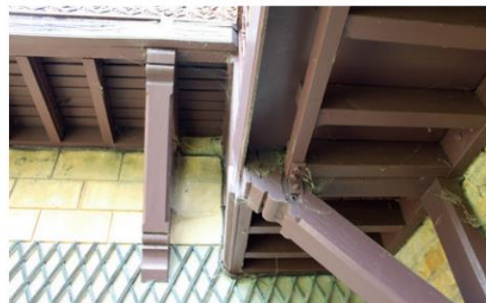
Analogies et différences entre les balcons des bâtiments A et B
