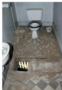
Sanitaires, carrelage et sondage du plancher
