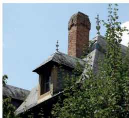
Bâtiment A, versant sud de la toiture et cheminée avec couronnement
