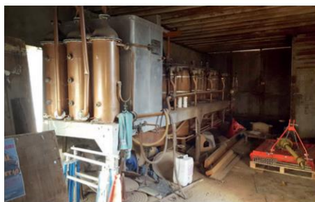
Hangar, vue des cuves
