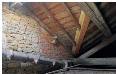
Pignon du bâtiment B et raccord entre les deux versants
