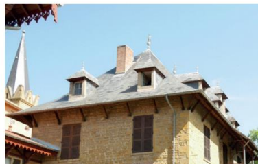
Bâtiment A, versant nord de la toiture. En arrière plan le clocher de l'église du Bois-d'Oingt
