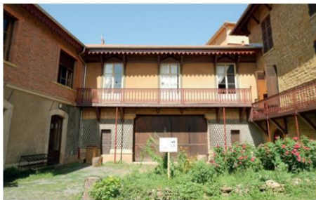
Bâtiment B, façade ouest
