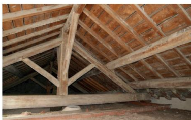
Combles du bâtiment C, ferme de charpente
