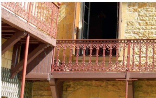
Analogies et différences entre les balcons des bâtiments A et B. Garde-corps en fonte.
