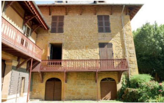
Bâtiment A, façade nord
