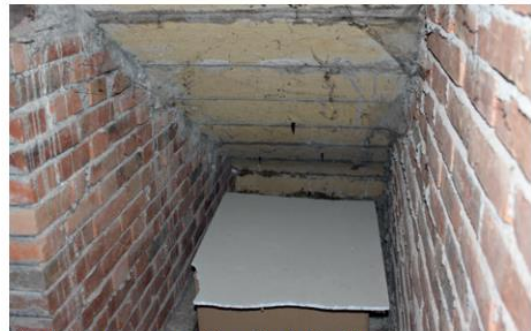
Vue du dessous de la première volée de l'escalier
