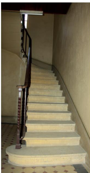
Escalier, première volée
