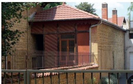
Bâtiment B, façade sud et mur aveugle côté est
