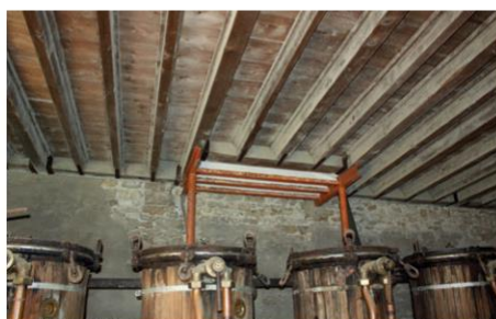
Vue de détail d'un renfort du plancher
