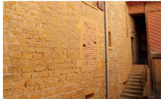
Bâtiment A, entrée secondaire condamnée côté est
