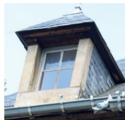
Bâtiment A, versant ouest. Corniche moulurée et corbeaux en bois
