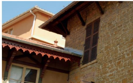
Raccord entre les bâtiments A et B
