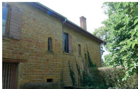
Bâtiment C, façade nord
