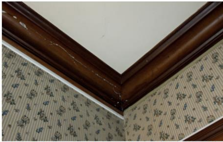
Salle de musique, moulures de couronnement en plâtre imitation bois
