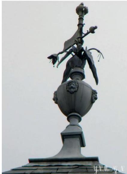
Bâtiment A, épi de faîtage surmontant la faitière (source flickr.com)
