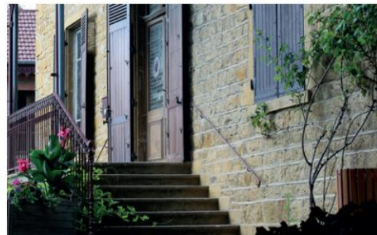
Bâtiment A, baies, perron d'entrée et angles sont marqués par l'utilisation de pierres de taille
