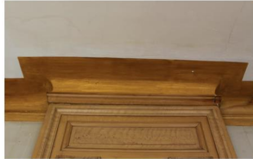
Salle de billard, trumeau. La corniche de couronnement ne correspond pas à celle d'origine et elle est de moins bonne facture
