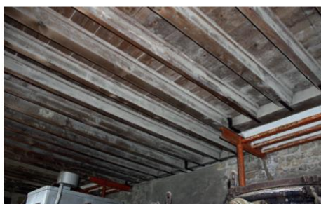
Vue des solives, du plancher et des renforts sous les cheminées de la salle de billard et de la salle 2
