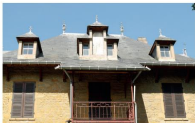
Bâtiment A, versant ouest de la toiture
