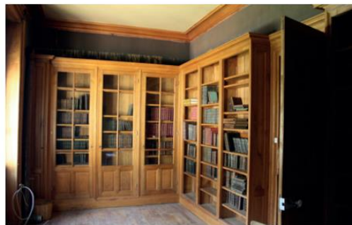
Vue de la bibliothèque et de ses rayonnages d'origine
