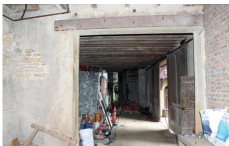
Hangar, vue depuis l'atelier (bâtiment C)
