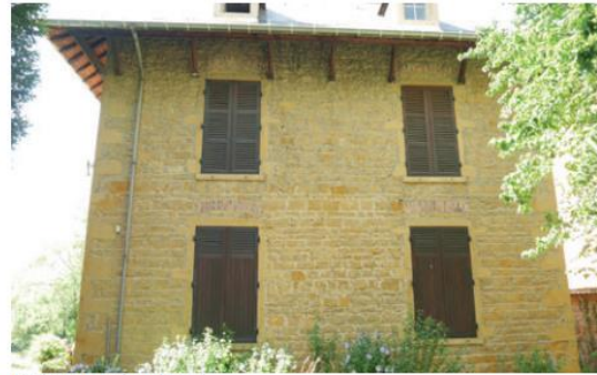
Bâtiment A, façade sud
