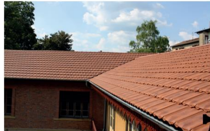
Jonction des couvertures en tuiles mécaniques des bâtiments B et C
