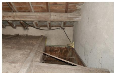
Vue au droit de la salle des sanitaires à l'étage
