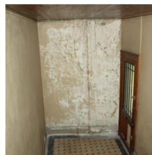
Entrée de la cage d'escalier
